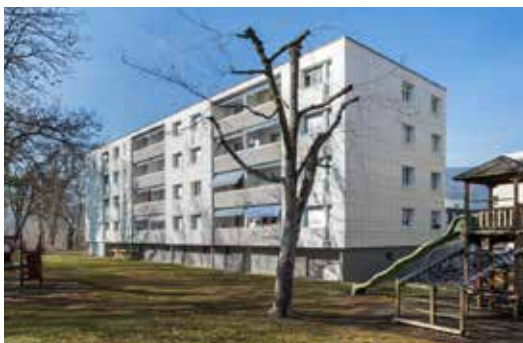
Boudry , 33/35, rte de la Gare
