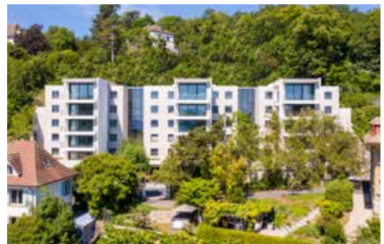
Neuchâtel , 119, rue des Saars / En construction, vente en PPE
