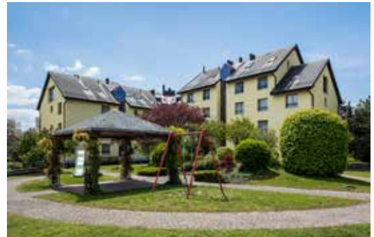
Yverdon-les-Bains , 21 à 31, rue d'Orbe
