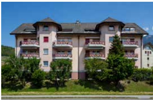
Bex , 47a à 47d, av. de la Gare
