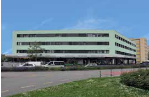
Carouge, 33 à 37, rte de Veyrier - 5/7, rte de la Fontenette
