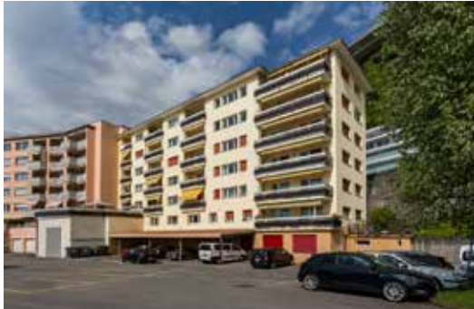
Veytaux , 6/8, rue de la Gare
