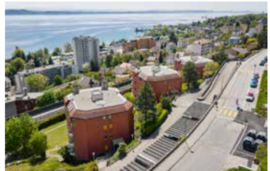
Neuchâtel , 24 à 28, rue des Berthoudes
