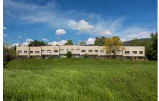
Onnens , 1 à 12, rte de la Gare
