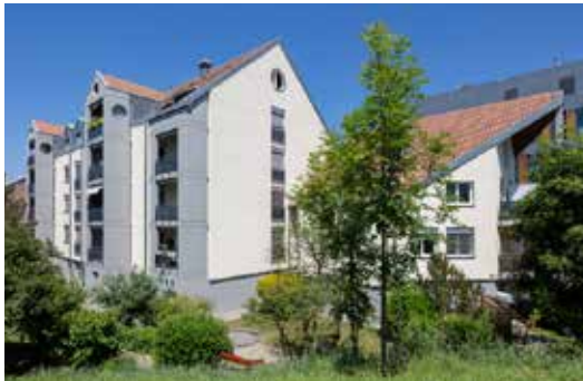
Yverdon-les-Bains , 10/12, rue de Plaisance
